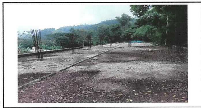
Foto 5: Impermeabilización de terraza
