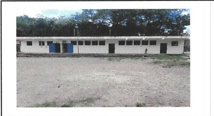
Foto 4: Pintura interior y exterior en aulas
