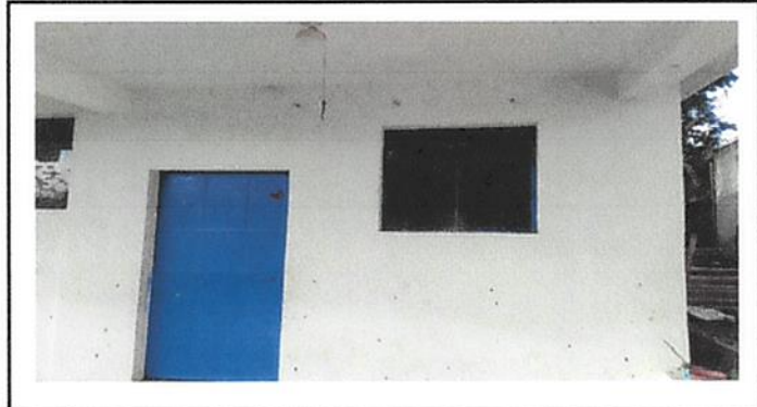
Foto1: Instalación de balcones por seguridad
