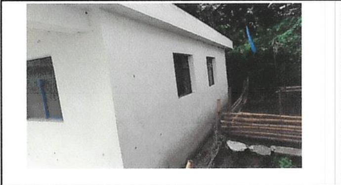
Foto 2: Instalación de balcones por seguridad
